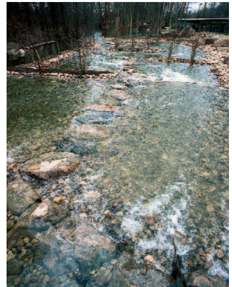
Der Umbau von Sohlabstürzen in Sohlgleiten (hier: Schwentine, Oehlmühle/Plön) ermöglicht die Durchgängigkeit der Gewässer für wandernde Fischarten und Wirbellose.
