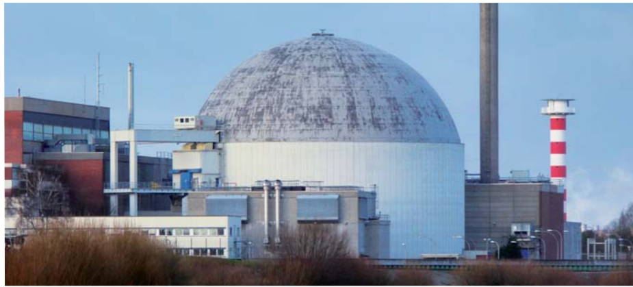
Das Atomkraftwerk in Stade an der Unterelbe ist das erste nach dem Atomausstieg stillgelegte Kraftwerk. Die schleswig-holsteinischen Standorte Krümmel, Brunsbüttel und Brokdorf müssen folgen.
