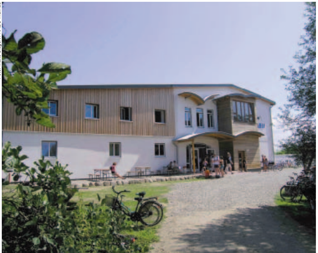
Nach zweijähriger Umbauzeit erstrahlt das renovierte NABU Infozentrum in neuem Glanz und lädt Interessierte ein, sich über das Wunder des Vogelzuges zu informieren.
