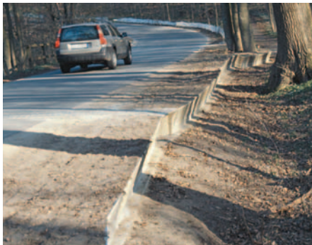
Eine ausreichend hohe Kante hindert die Amphibien die Straße direkt zu überqueren.
