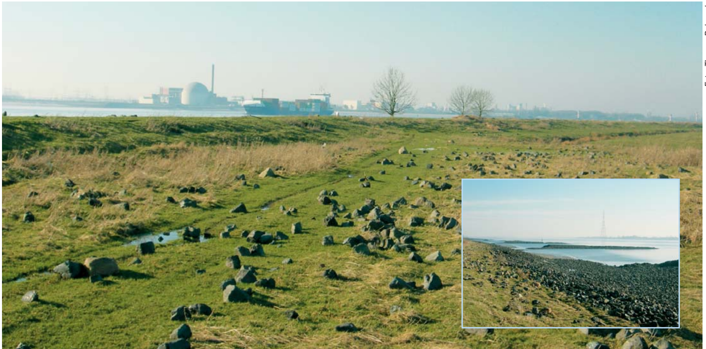
Wie Hagelkörner liegen die schweren Schlackesteine im Grünland hinter dem Deich. Die Wucht der Flut in Verbindung mit dem Sog der Bugwelle entwickelt zerstörerische Kräfte. Ort: Julssand Januar 2008.
